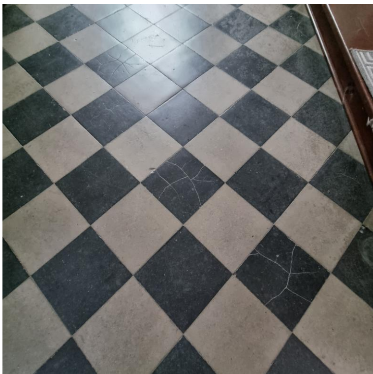
FOT. 8. Komarówka Podlaska, kościół, posadzka w transepcie po lewej, widoczne spękania, 2024
