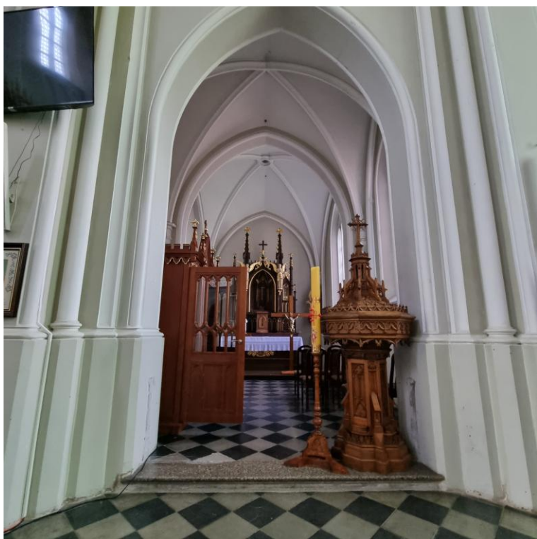
FOT. 6. Komarówka Podlaska, kościół, wejście do kaplicy prawej, widoczna posadzka i stopień, brak podstopnicy, 2024.
